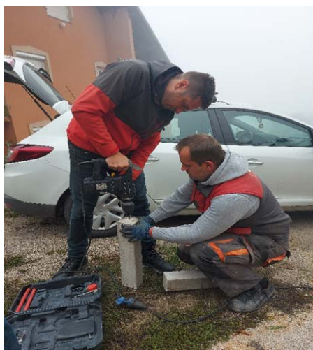
Slika 1. Način stabilizacije GNSS tačke.
