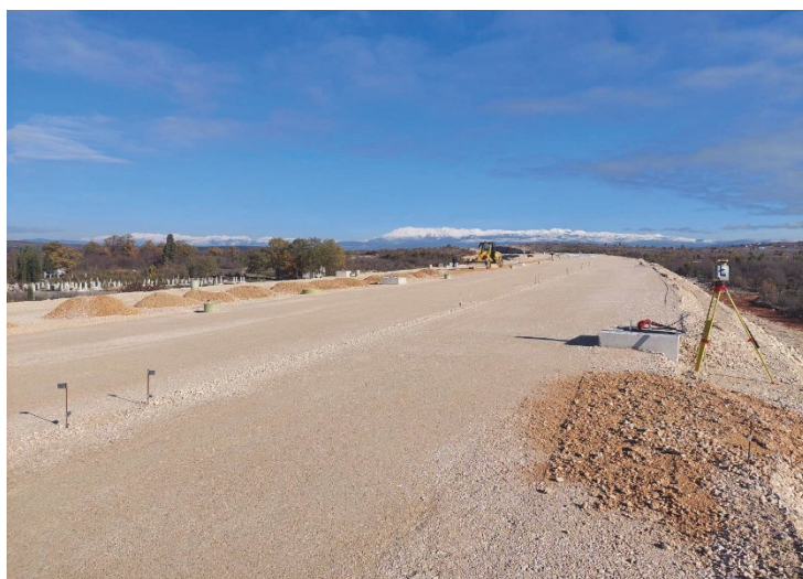
Slika 2. Iskolčenje za potrebe postavljanja sloja tampona 0-100 mm.
