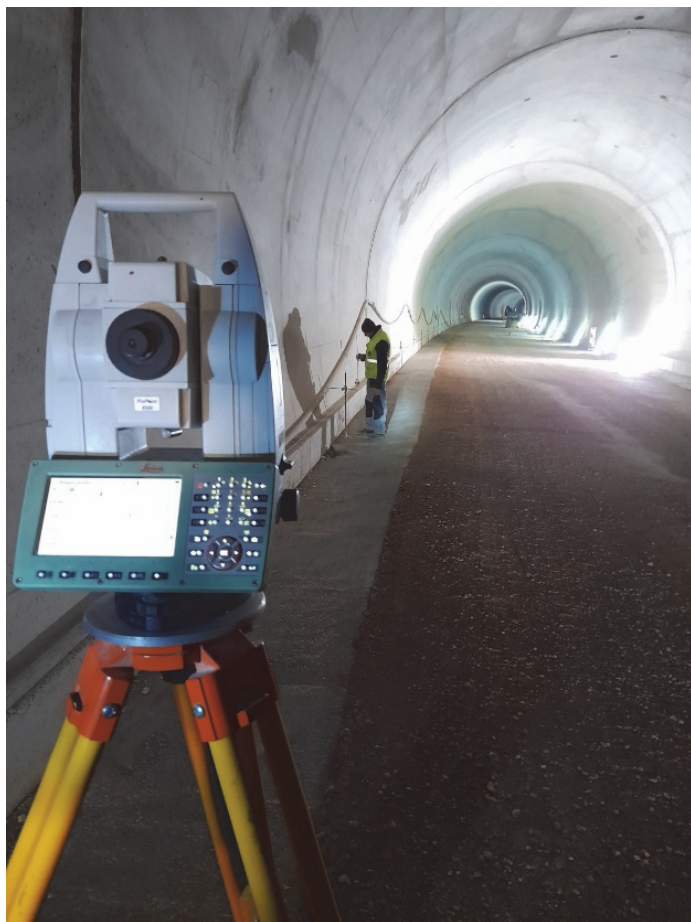
Slika 4. Kontrolna mjerenja unutar tunela Počitelj.
