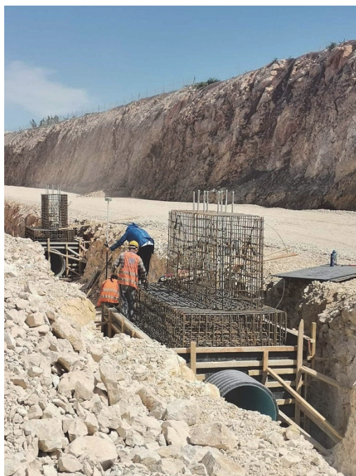
Slika 21. Kontrola oplata temelja za signalizaciju.
